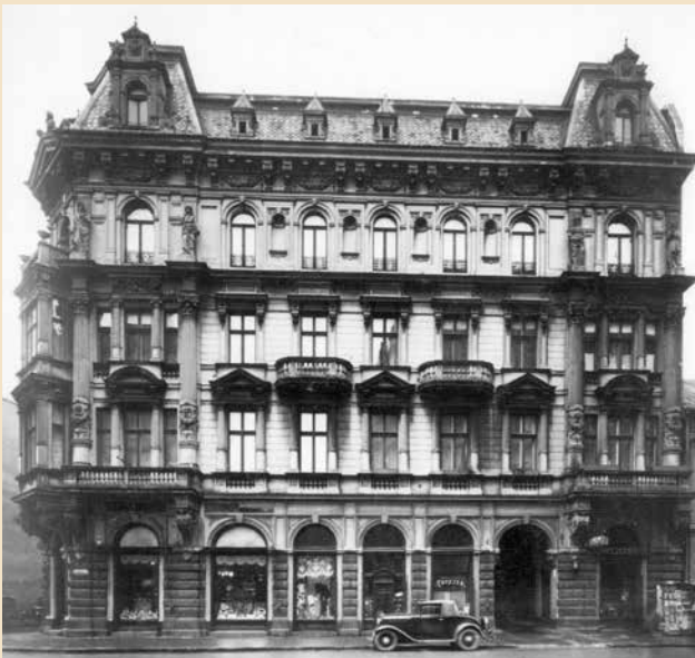
Kamienica Wedla przy ul. Szpitalnej w Warszawie, 1927 r.
