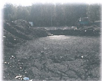
Stabilizacja tlenowa I° pofermentu na placu technologicznym (uformowany basen)
