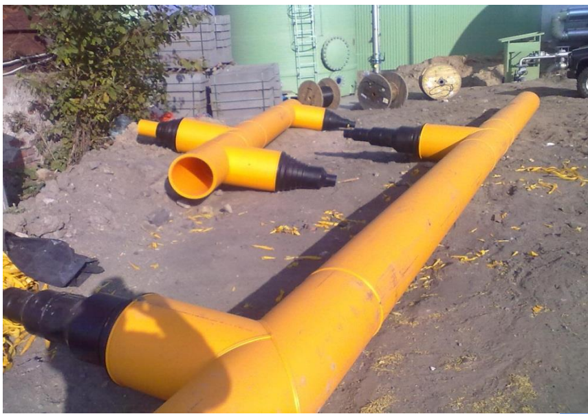
Podłączenie gazociągów zbiorczych do generatorów prądotwórczych.
