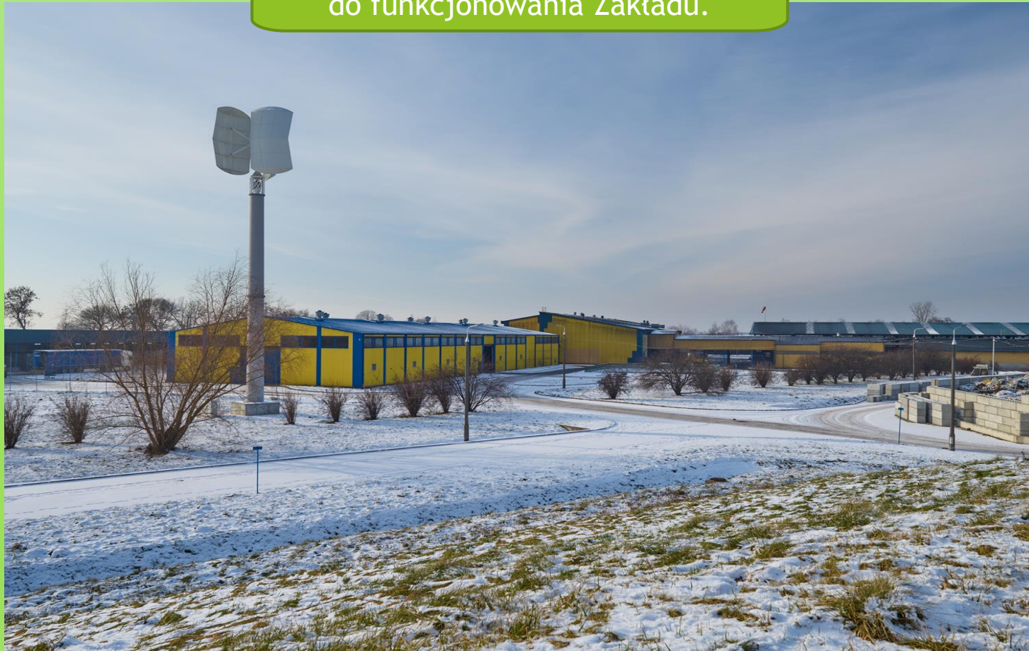
Zakład przetwarzania odpadów - widok ze zbocza kwatery
