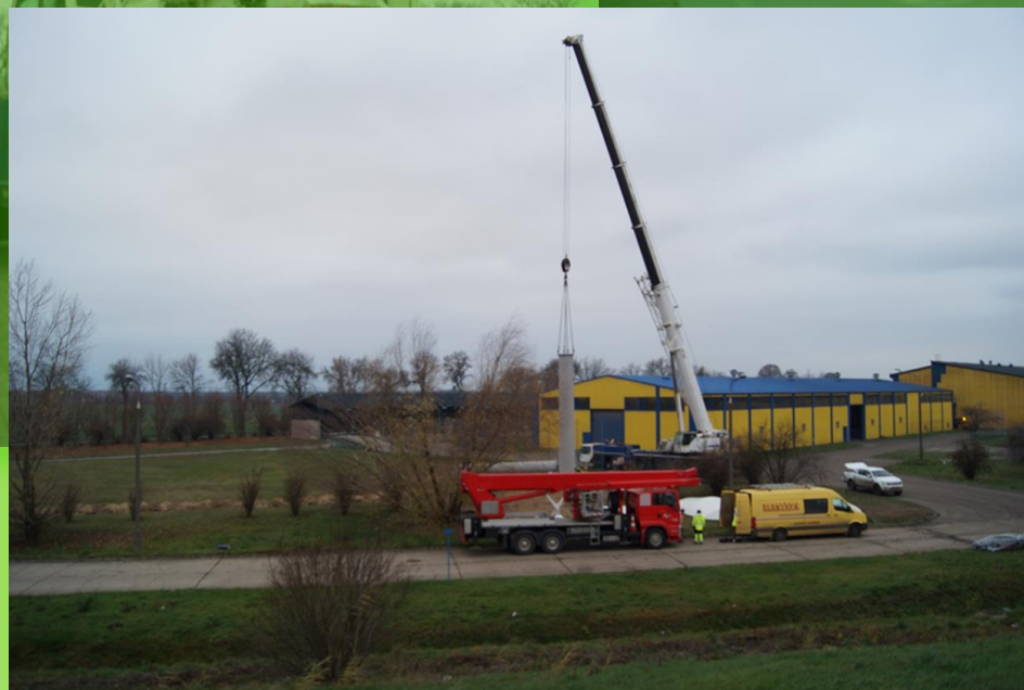
Montaż turbiny wiatrowej - maszt o wysokości 24 m
