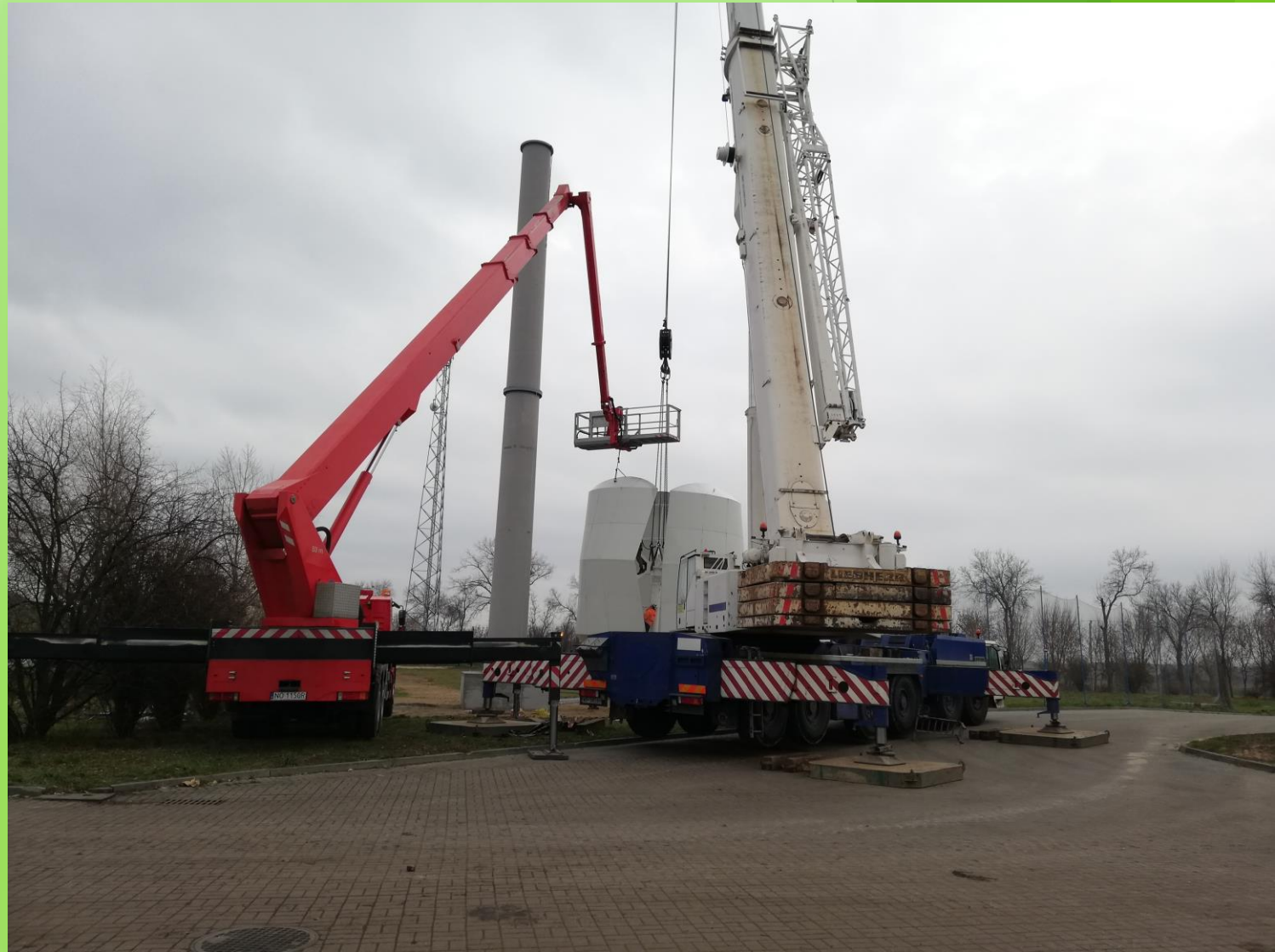
Montaż śmigła turbiny wiatrowej
