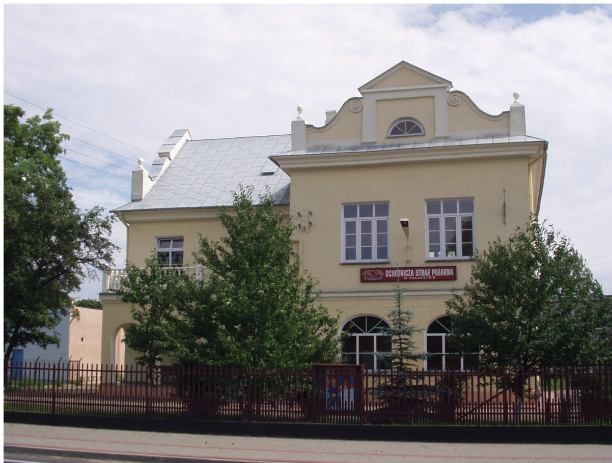
Budynek Ochotniczej Straży Pożarnej w Kałuszynie
