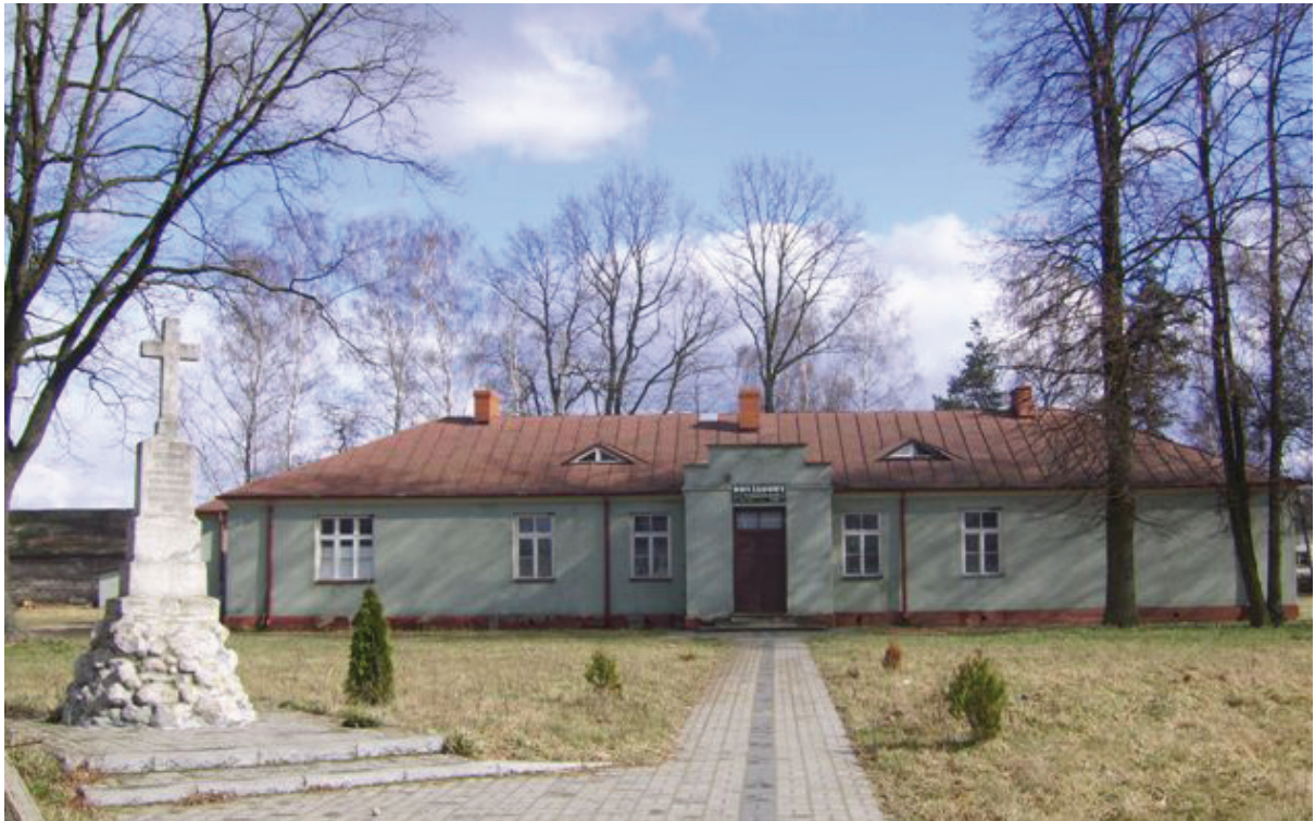
Dom Ludowy, Rzeszotków (Gmina Paprotnia)
