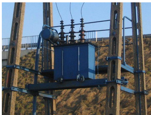
Ilustracja 67 Transformator LPN na sieci PKP PLK S.A.
