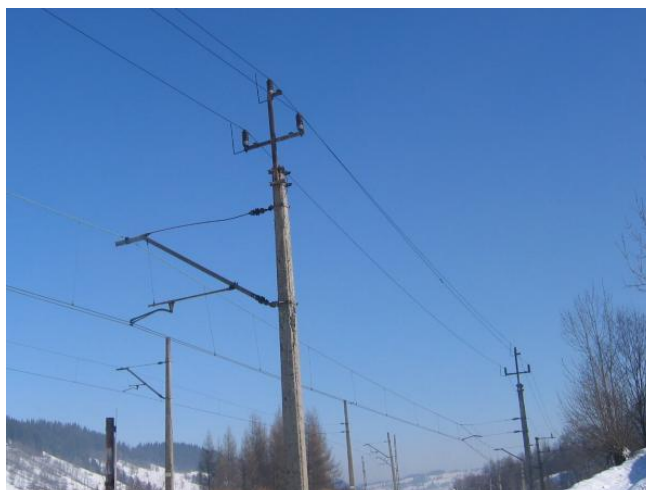
Ilustracja 68 LPN biegnąca po konstrukcjach wsporczych sieci trakcyjnej
