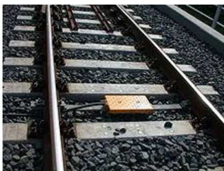
Ilustracja 63 Zabudowa eurobalisy w torze kolejowym
