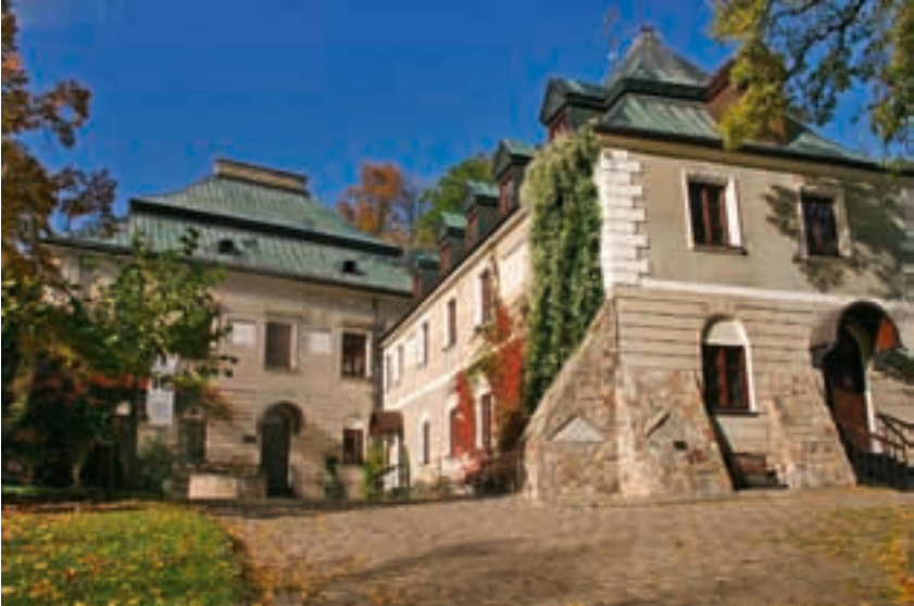
The Odrowąż Palace in Chlewiska
